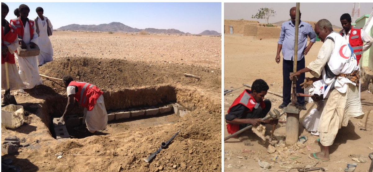
Konstruktion af en vandtank ved lejren for de internt fordrevne mennesker, Derudeb, og vedligeholdelse af en håndpumpe af vandkomiteemedlemmerne.
